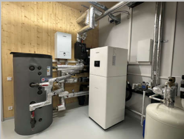
Sole-Wasser-Wärmepumpe (Vaillant)
