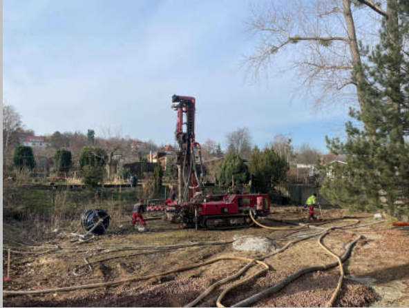
Bohrgerät Erdwärmesonden in Aktion
