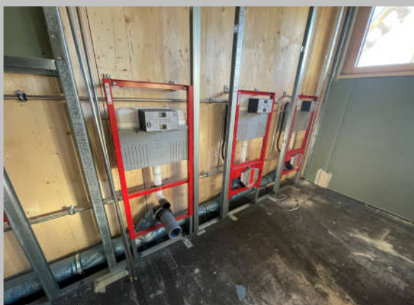
Sanitärständerwand an Massivholzwand
