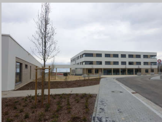
Schulgebäude, Ansicht Zugangsseite
