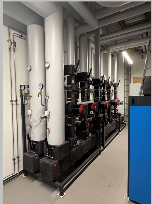
Heizungsverteiler vorgefertigt ab Werk (Pewo)
