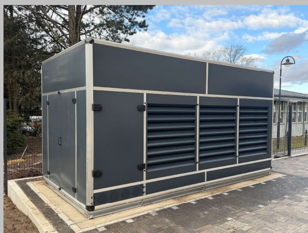
Luft-Wasser-Wärmepumpe
