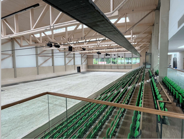
Tribünenbereich mit IRLED Strahlungsheizung (Entwicklung © advigeo)
