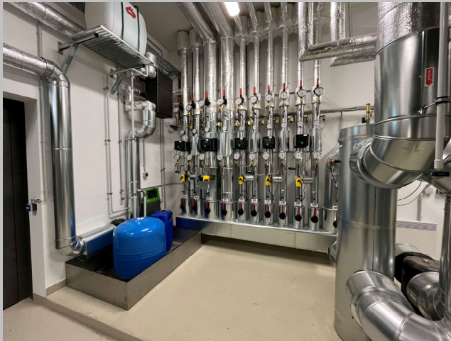
Heizungsverteiler, Glykoldosierung
