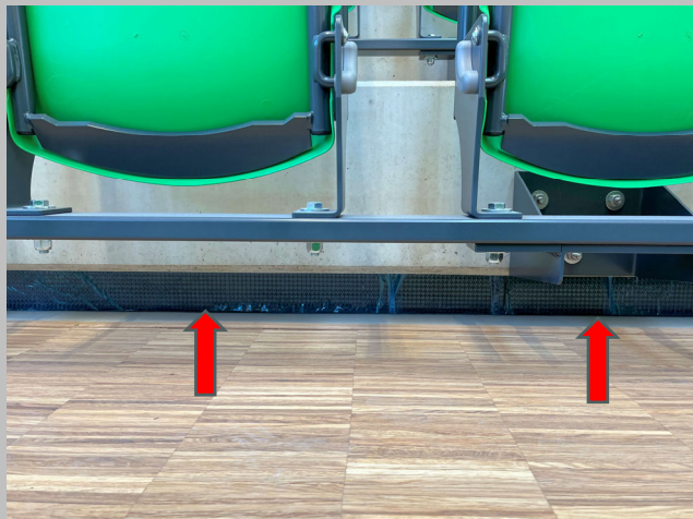
Stufenluftauslässe unterhalb der Sitzreihen
