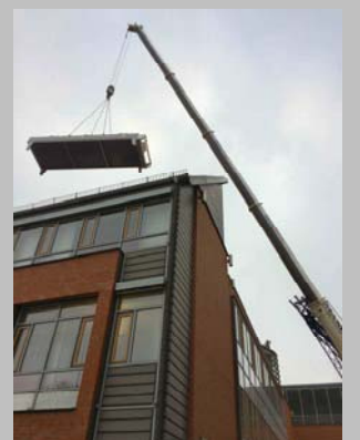
Montage Dachkühler
