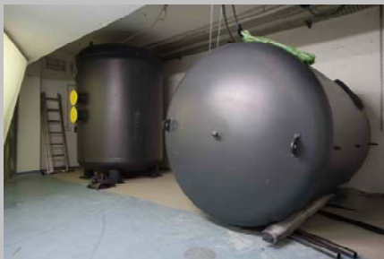
Montage Kaltwasserpufferspeicher
